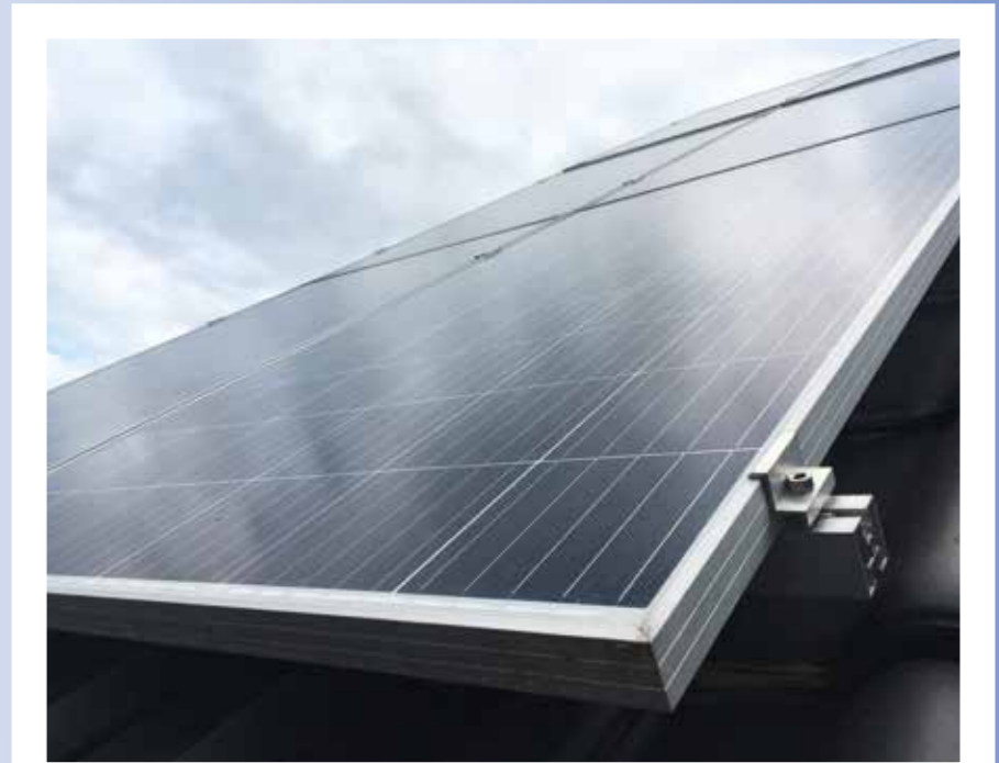
Panele powinny być położone pod kątem 30-40 stopni od poziomu
